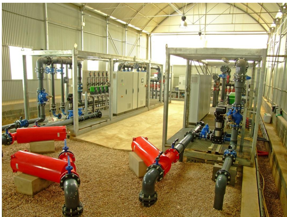
Figura 4 – Central de fertirrega e os seus diversos componentes.
